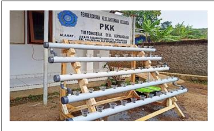
Gambar 2. Rangkaian instalasi pipa paralon sistem DFT
